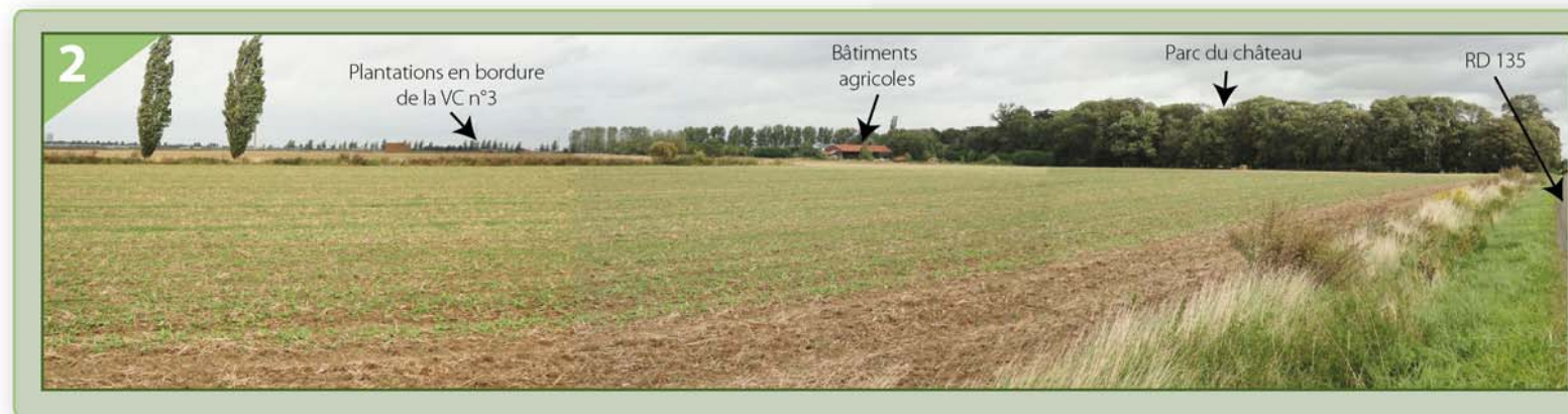
Vue depuis l'angle Sud-Ouest
